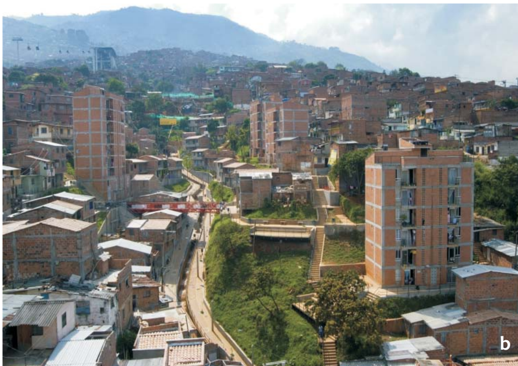
b) Proyecto de vivienda y mejora- miento del entorno de la quebrada Juan Bobo Fuente: EDU
